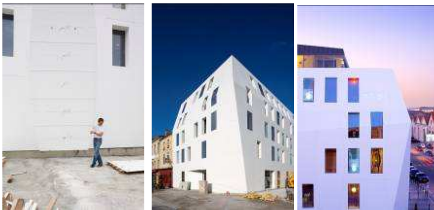
Отель SeeKoo в Бордо, облицовка фасада здания полностью выполнена из DuPont™ Corian®
